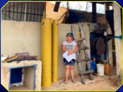
Cooperado Aguilu de Souza Carneiro, representado pela esposa Cláudia de Paula Carneiro - Tubos metálicos para elevador
